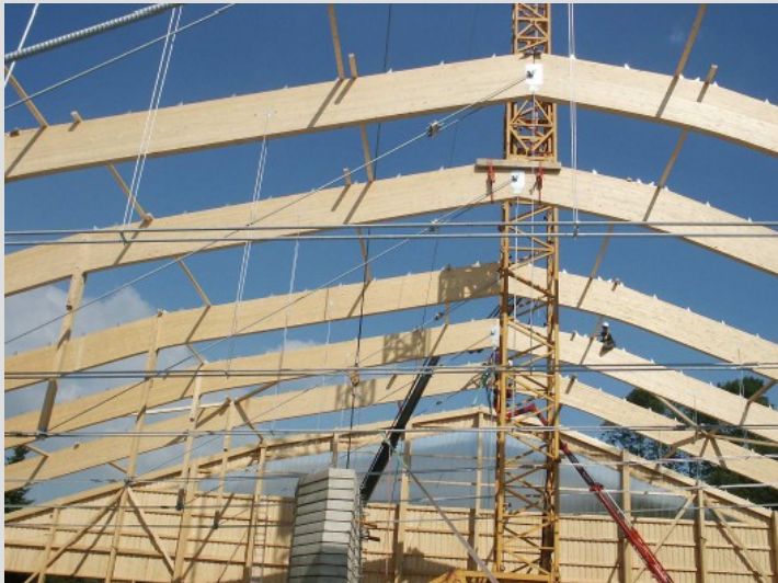
Eishalle Brännli, Hasle-Rüegsau
