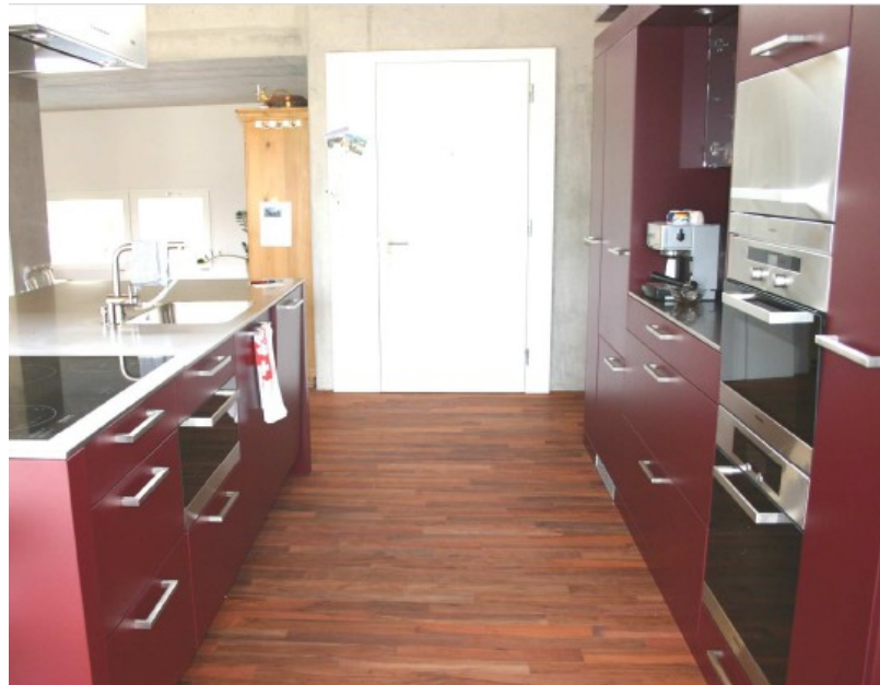
Riemenparkett CH-Apfel, baustellengeölt
