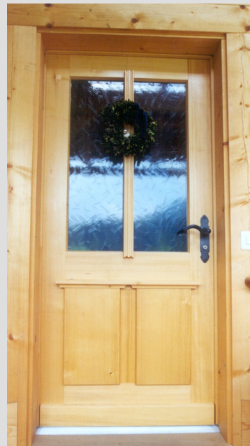
Gestemmte Türe in Fichte massiv mit einer senkrechten Sprosse, zwei überschobenen Füllungen und Wetterschenkel.
