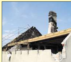
Das Dach war vollständig zerstört und wurde abgebrochen.
