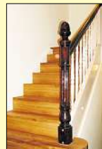
Das Treppenhaus ist wieder wie neu.
