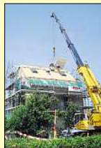
Fertigelemente per Autokran.
