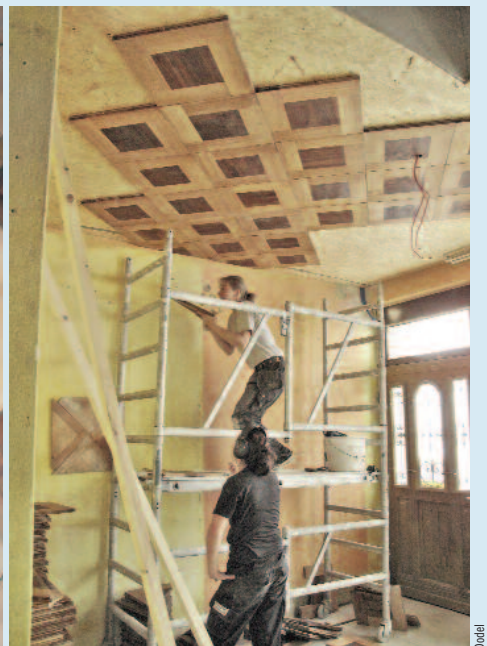
Das Verlegen des Parketts an den Wänden erfolgte ohne Leisten. Zuschneiden lautete hier die Devise.
